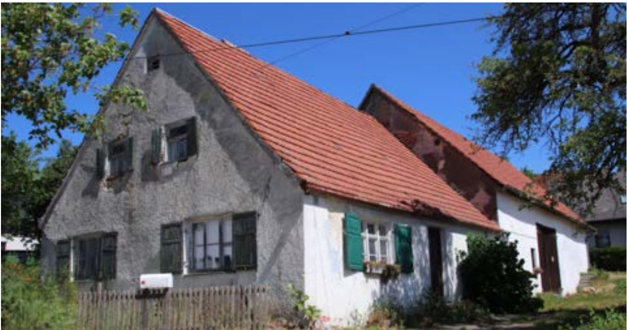
Abbildung 52: Vorherrschende Baustruktur – Bauernhaus, Ortsteil Oberliezheim
