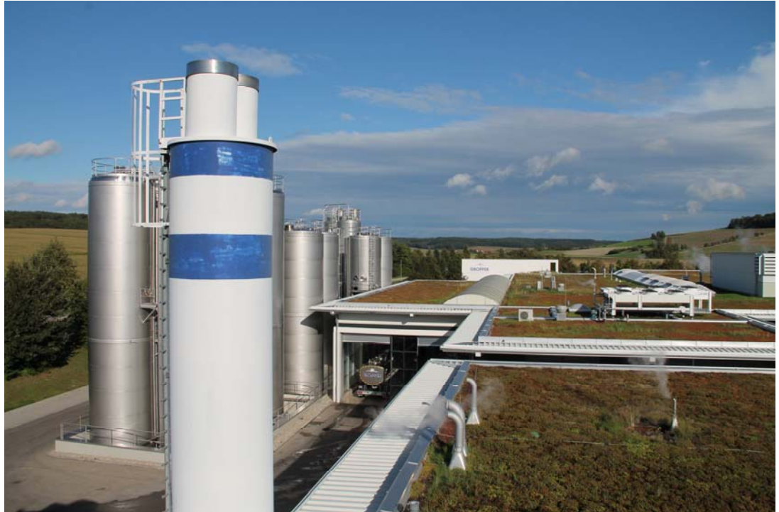
Foto 3: Blick vom Dach des neuen BHKW-Gebäudes in Richtung Westen auf die bestehenden Betriebsgebäude der Fa. Molkerei Gropper GmbH & Co. KG.
