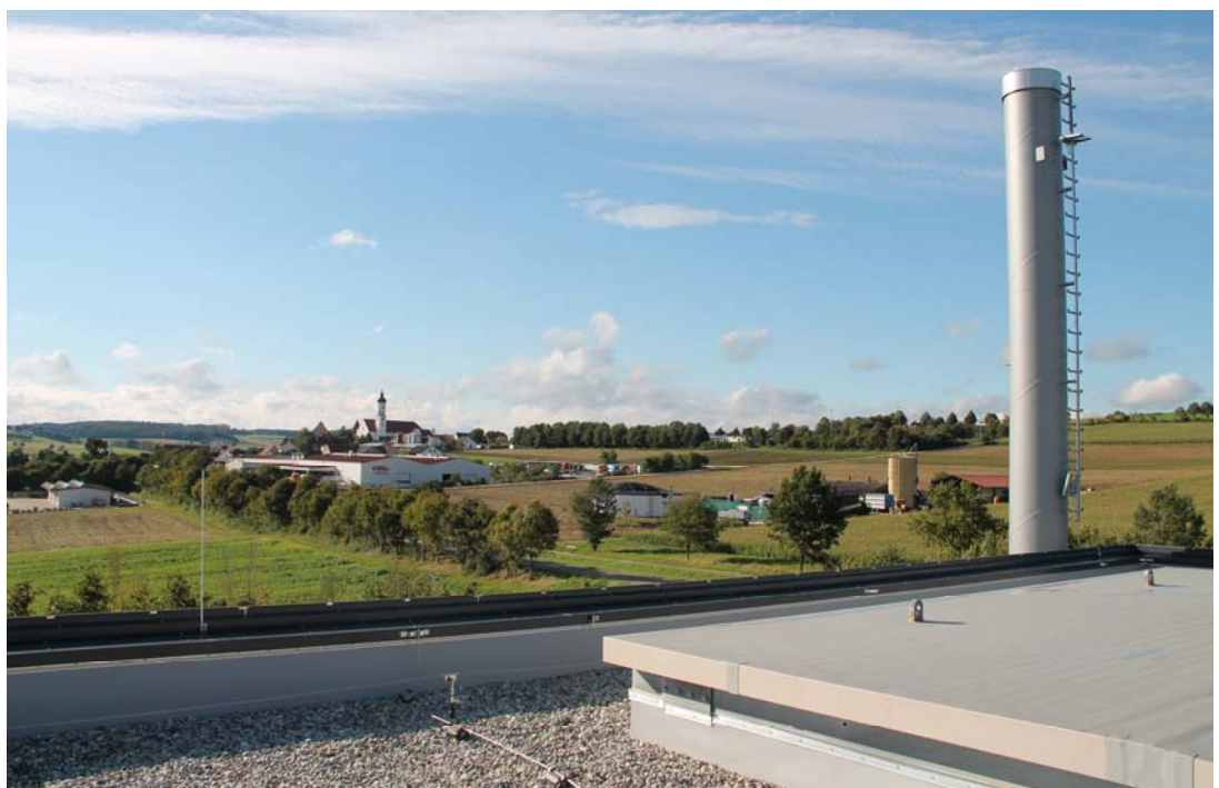
Foto 6: Blick vom Dach des neuen BHKW-Gebäudes in Richtung Westen zur Ortslage Bissingen. Diese liegt allerdings wenigstens 725 m von den neu geplanten Lkw- und Pkw-Stellplätzen entfernt.
