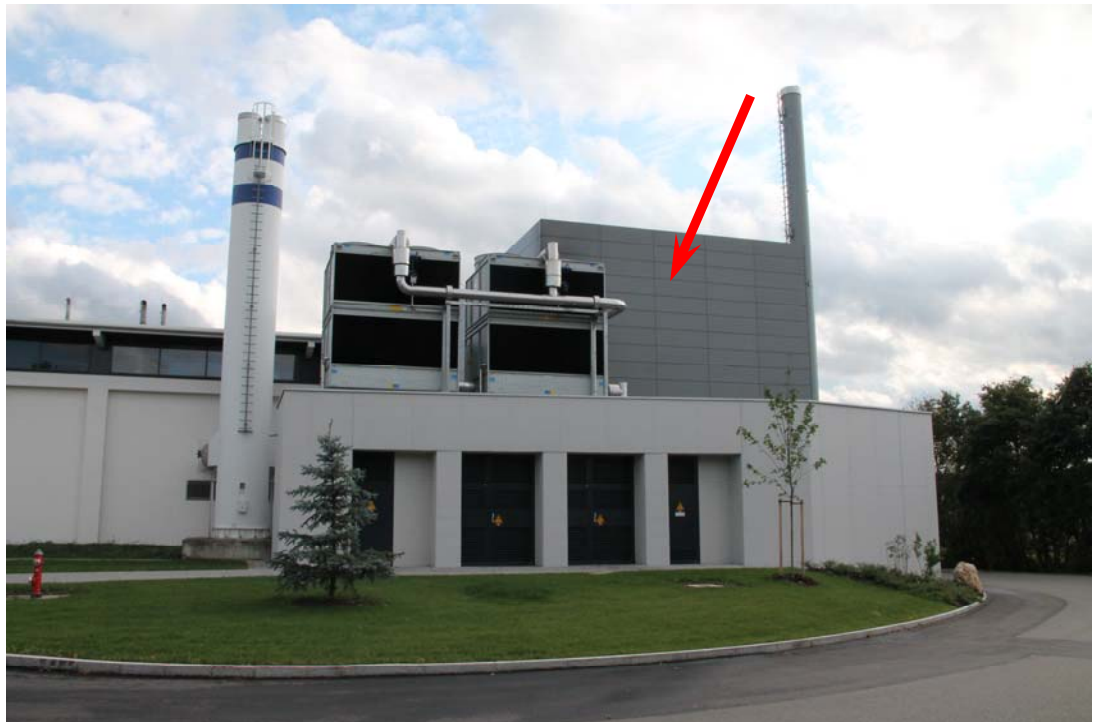
Foto 2: Blick aus Richtung Norden auf das BHKW-Gebäude (Pfeil), das sich in westliche Richtung an das bestehende Kesselhaus (links im Foto) anschließt.
