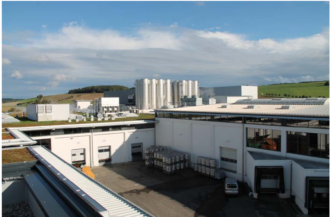
Foto 4: Blick vom Dach des neuen BHKW-Gebäudes in Richtung Südwesten auf die bestehenden Betriebsgebäude der Fa. Molkerei Gropper GmbH & Co. KG.
